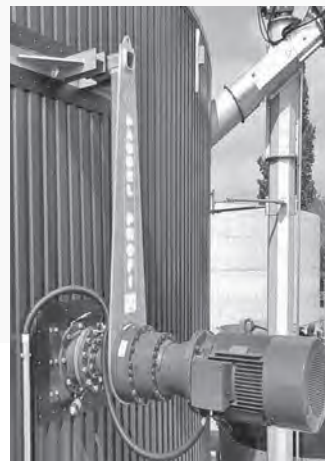
Abb. Planetengetriebe 22 kW Lärmpegel >69 dB(A)
