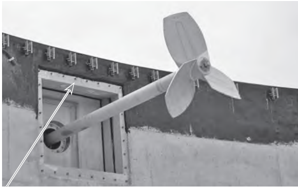
Betonschalung zur leichteren Montage
